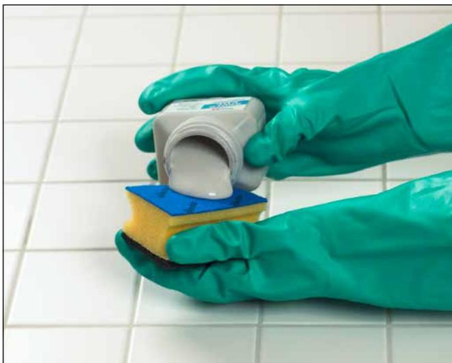
**3** Nach dem Abtrocknen von Fliese und Fuge ist Sopro FugenFrisch auf einen Schwamm oder einem Pinsel aufzutragen.
