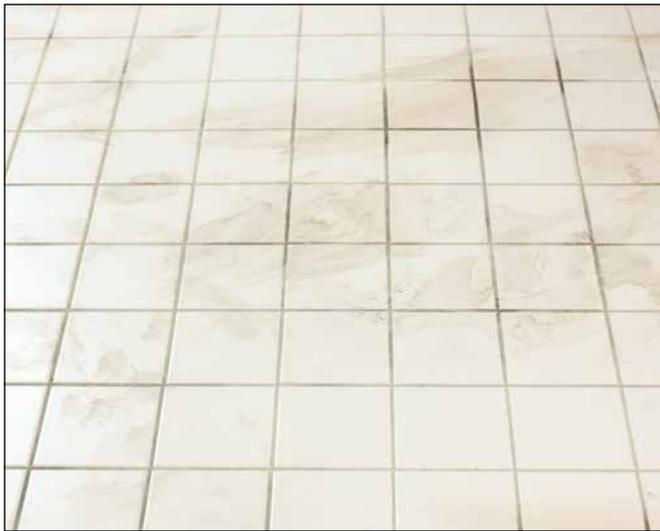
**1** Alter, verschmutzter Belag mit unansehnlichen, verfärbten und verfleckten Fugen.
