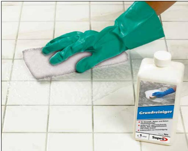
7 Die Fläche ist mit warmem, mit Sopro Grundreiniger gemischten, Wasser zu benetzen. Nach einer kurzen Einwirkzeit von 2–3 Minuten kann die Fläche mit Sopro Abwaschpad fein und dem verdünnten Reinigungsmittel vor-gewaschen werden.
