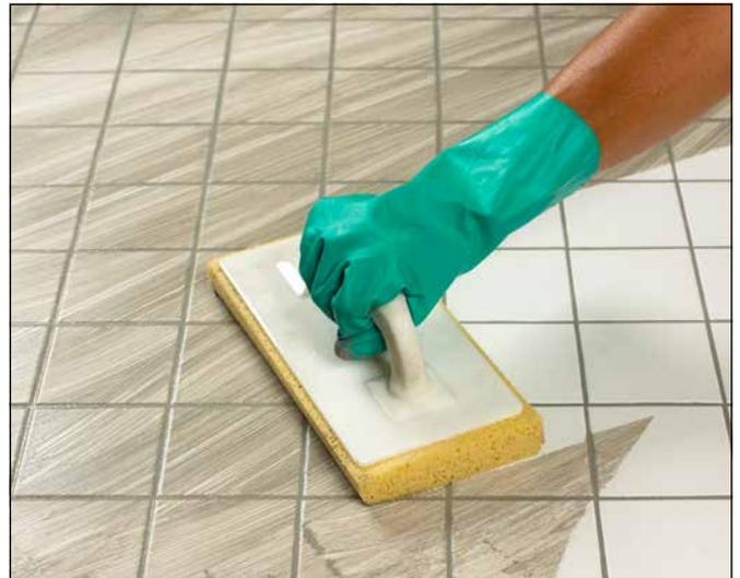
8 Entfernung der restlichen Schleier mit Sopro Schwammbrett und ausreichend frischem Wasser. Anschließend mit einem sauberen Tuch die Fläche abwischen.
