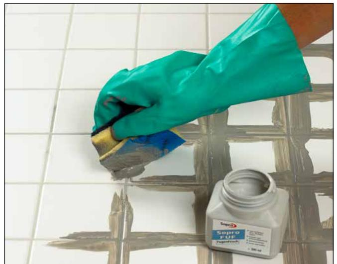
**4** Die Fugen sind danach deckend (nicht überschüssig) mit Sopro FugenFrisch zu beschichten.
