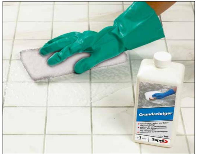
**2** Reinigung der verschmutzten Fugen mit Sopro Abwaschpad grob bzw. fein (je nach Fliesenoberfläche) und Sopro Grundreiniger oder Sopro Bio-Intensiv-Reiniger.
