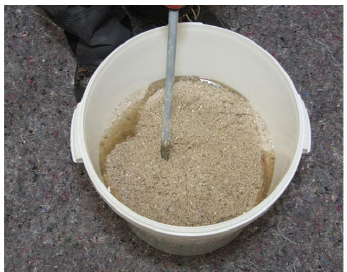
6 Sopro EpoxiEstrichKorn und Sopro BauHarz mit geeignetem Rührquirl zu einem klumpenfreien, homogenen Mörtel mischen.
