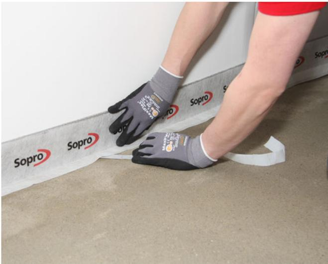
**7** Im Anschlussbereich von Wand und Boden den selbstklebenden Sopro EstrichRanddämmstreifen stellen.
