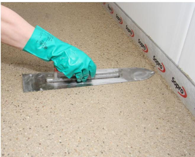
**11** Durch Verdichten und Glätten mit dem Estrichschwert wird eine homogene, ebene Oberfläche erzielt.
