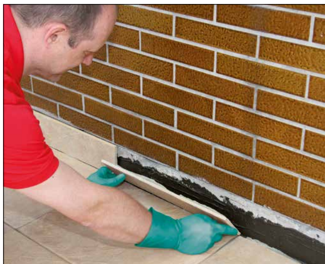
20 ... und Ansetzen der Sockelfliese.
