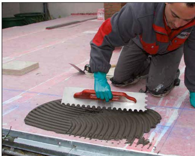
**7** ... mit der Glättkelle eine Kontaktschicht aufbringen und direkt danach das Kammbett mit der passenden Zahnkelle aufziehen.
