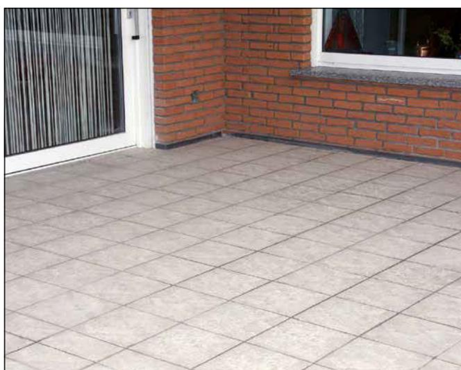
**11** Fertig verlegter Belag mit Sopro megaFlex S2 turbo.
