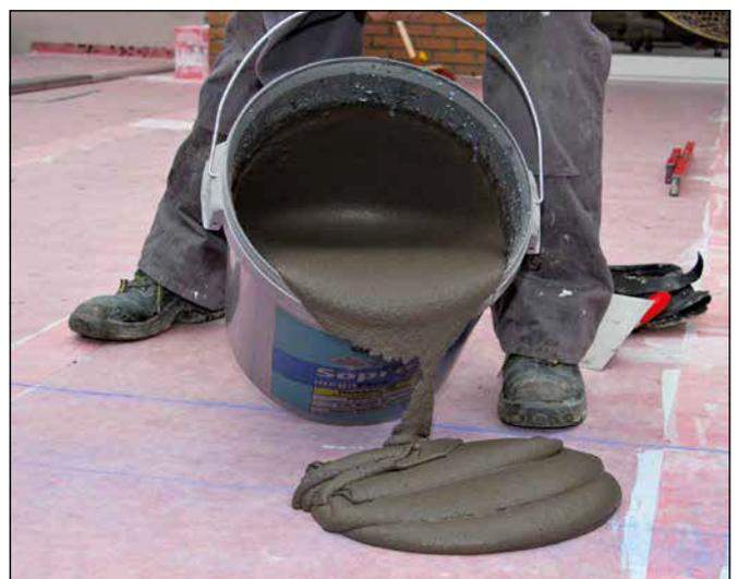
6 Sopro megaFlex S2 turbo auf der abgedichteten Fläche (z. B. Sopro AEB® plus, Sopro TurboDichtSchlämme 2-K) ausgießen, ...
