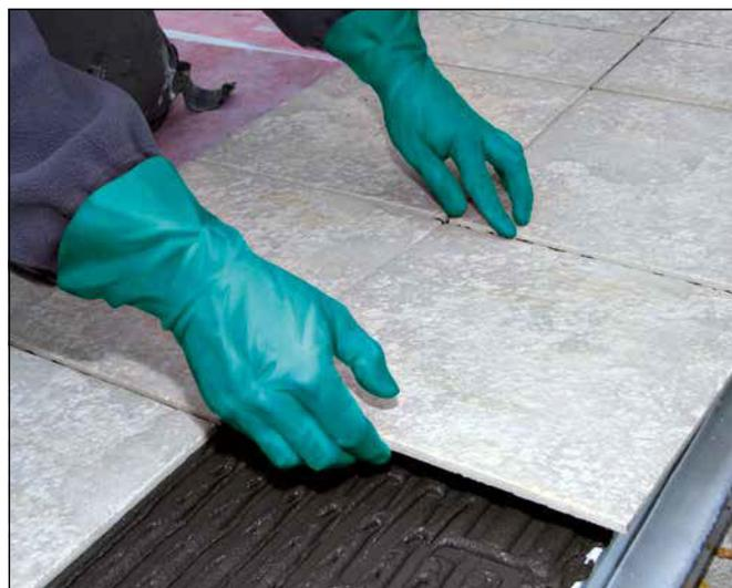
**8** Fliesen unter Druck einlegen und justieren. Fugennetz vor der Erhärtung auskratzen.
