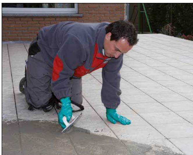
**9** Verfugung der Fläche mit einer Sopro Fugenmasse (z. B. Sopro Flex-Fuge plus) bereits nach ca. 3 Stunden möglich.
