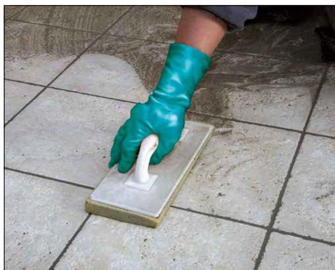
**10** Abwaschen des Fliesenbelages nach ausreichender Standzeit der eingefügten Sopro Fugenmasse.
