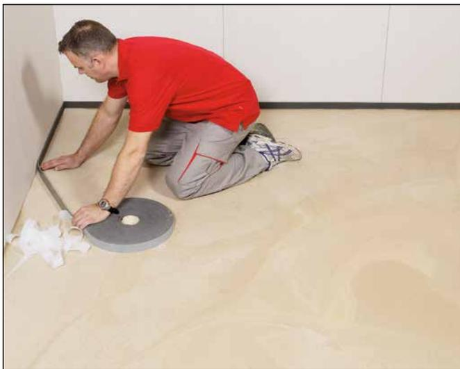
**1** Um Schallbrücken zu vermeiden, sind vor Beginn der Fliesenverlegearbeiten Randdämmstreifen (z. B. Sopro RandDämmStreifen) je nach Belagsstärke anzuordnen.
