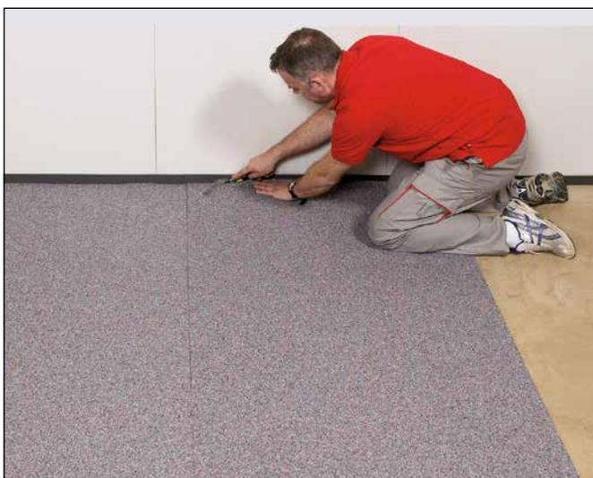
**3** Die Bahnen vor der Verlegung etwas größer zuschneiden, vollflächig lose auslegen ...
