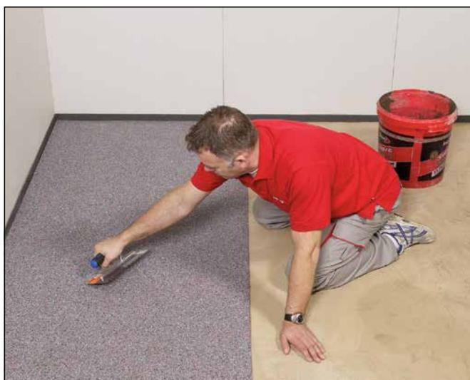
**6** Die einzelne Bahn faltenfrei in das Mörtelbett einlegen und mit der glatten Seite der Zahnkelle andrücken und abstreichen, sodass keine Lufteinschlüsse unter der Bahn verbleiben.
