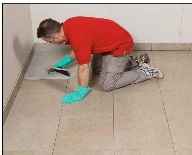
**12** Nach Erreichen der Begeh- und Verfugbarkeit wird der keramische Fliesenbelag mit z. B. Sopro DF 10® Design-Fuge Flex verfugt.
