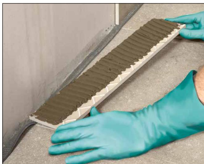
**10** Die Sockelfliesen werden mit rückseitig aufgetragenem Verlegemörtel verklebt. Der Randdämmstreifen muss zwischen Sockelfliese und Bodenfliese herauschauen...
