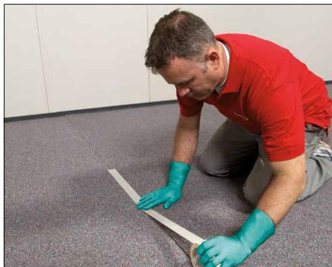
**8** Zur Vermeidung von Mörtelbrücken (Körperschallbrücken) können die Stöße der Bahnen mit Klebeband überklebt werden.
