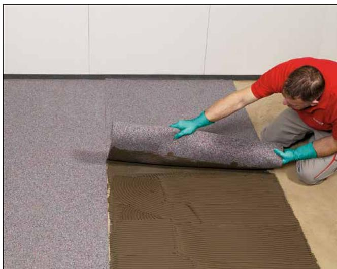
**7** Die nachfolgende Bahn dicht anlegen und stoßen. Dabei darauf achten, dass kein Verlegemörtel durch den Stoßbereich austritt.
