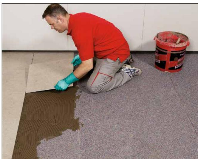
**9** Nach Erhärtung des Verlegemörtels kann die Fliesenverlegung z. B. mit Sopro's No. 1 schnell direkt auf der Bahn erfolgen.
