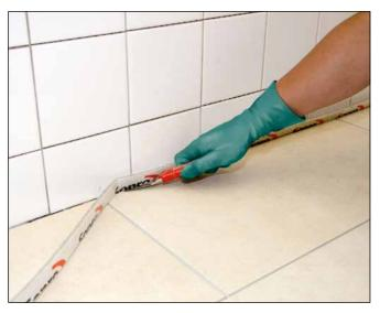
18 Abschneiden des Sopro RandDämmStreifens mit einem Cutter-Messer.
