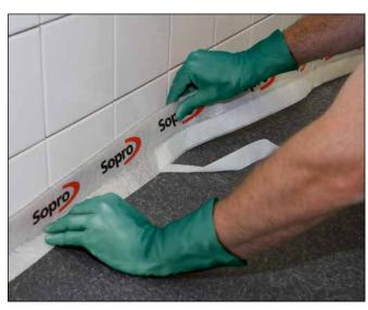
$\begin{tabular}{lll} \bf 2 & Anbringen & des & selbstklebenden & Sopro & RandDämmStreifens & nach & Trocknung & des & Sopro & HaftPrimer & (1-2 Stunden). \\ \end{tabular}$
