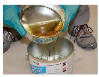
Die Fläche ist mit Sopro Epoxi-Grundierung bzw. Sopro MultiGrund (einkomponentig) zu grundieren, um eine Rückdurchfeuchtung der Anhydritestrichkonstruktion zu verhindern. Komponente B der Sopro Epoxi-Grundierung restlos in den Behälter der Komponente A schütten und homogen vermischen.
