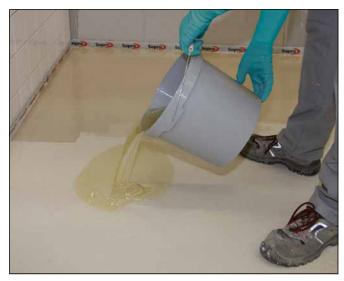
Nach Erreichen der Begehbarkeit und Prüfung der Restfeuchte die Sopro Epoxi-Grundierung bzw. Sopro MultiGrund auf den Untergrund aus Sopro AnhydritFließSpachtel ausgießen ...
