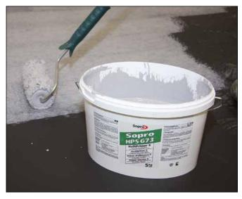
Sopro HaftPrimer S auf den unbesandeten Gussasphaltestrich aufrollen. Bei saugenden Untergründen (z.B. Anhydritestriche) empfehlen wir Sopro Grundierung.
