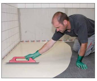
6 Mittels Glättkelle oder Rakel ist Sopro AnhydritFließSpachtel bis zur erforderlichen Schichtdicke zu verteilen.
