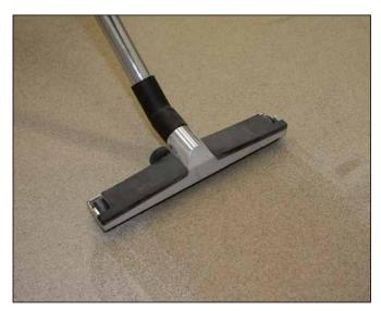
Überschüssigen Quarzsand nach vollständiger Trocknung der Sopro Epoxi-Grundierung (nach ca. 24 Stunden) bzw. des Sopro MultiGrundes (nach 30–40 Minuten) mit einem Industriesauger oder einem Besen aufnehmen.
