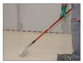
Zur Entlüftung eingeschlossener Luftblasen kann die frische Spachtelmasse mit einer Stachelwalze durchgerollt werden. Zur weiteren Bearbeitung Sopro AnhydritFließSpachtel mind. 24–36 Stunden trocknen lassen bzw. Restfeuchte durch CM-Messung überprüfen.
