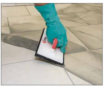
16 Einfugen der Sopro Fugenmasse (z.B. Sopro DF10® DesignFuge Flex, Sopro Brillant® PerlFuge).
