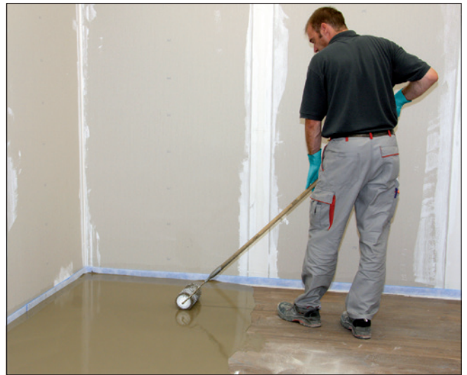
8 Mit einer Stachelwalze wird die aufgebraute Spachtelmasse verteilt und verdichtet, um eine planebene Oberfläche zu erhalten.
