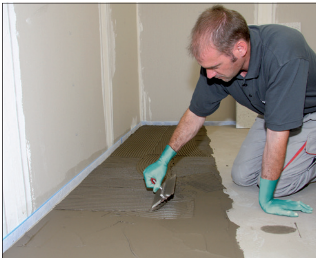
9 Nach Trocknung der Spachtelmasse wird auf den planebenen Untergrund z. B. Sopro's No.1 Flexkleber aufgetragen.
